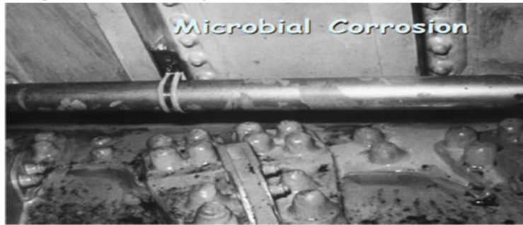
Gambar 3.18 Korosi Mikrobial
