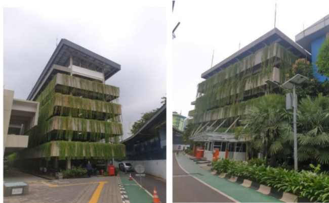
Gambar 3. Gedung Parkir Motor
